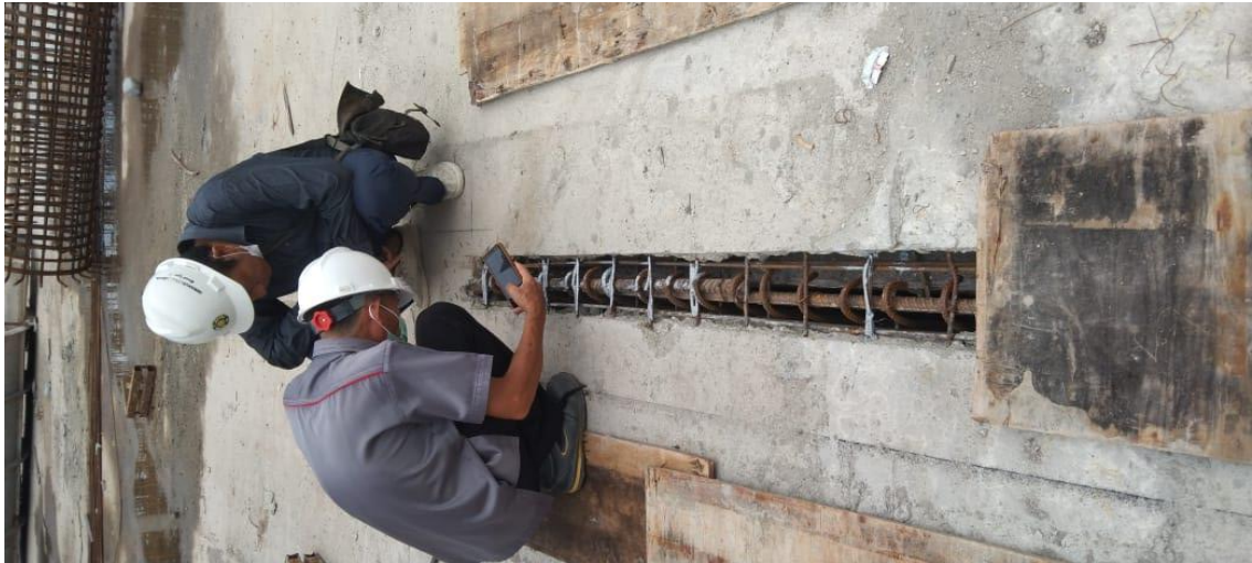
Gambar 2. Pemeriksaan Sebelum pengecoran
