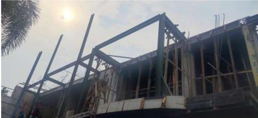
Gambar 5 Renovasi menggunakan gabungan dengan struktur Baja
