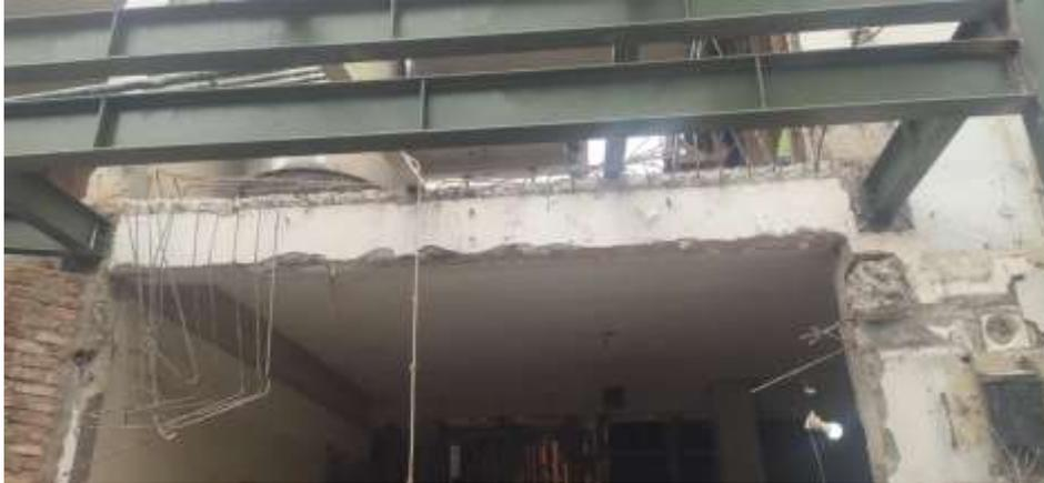
Gambar 7 Pemasangan rebar dan anchor bolt dengan chemical
