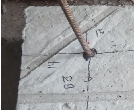
Gambar 13. Hasil kuat tarik rebar T13 pada kedalaman 11 cm
