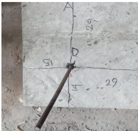
Gambar 11. Hasil kuat tarik rebar T10 pada kedalaman 12 cm
