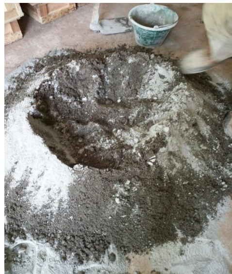
Gambar 2. Pembuatan Campuran Beton
