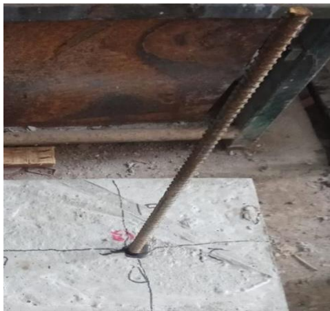
Gambar 14. Hasil kuat tarik rebar T13 pada kedalaman 13 cm
