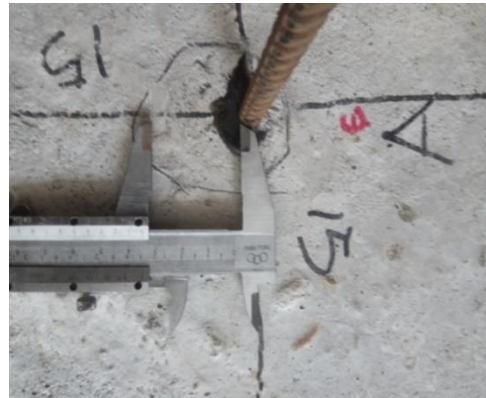
Gambar 9. Hasil kuat tarik rebar T10 pada kedalaman 6 cm
