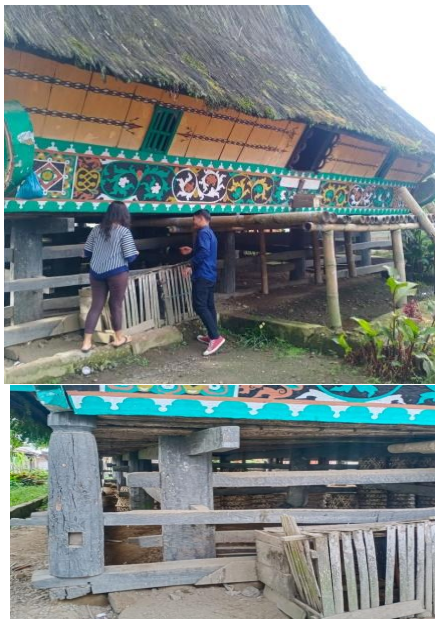
Gambar 7. Bagian bawah rumah adat karo yang tidak digunakan lagi untuk tempat memelihara hewan ternak, sumber gambar : survey lokasi
