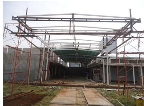
Gambar 2. Kondisi struktur cantilever tipe I dengan kolom pipa masih ditopang perancah.
