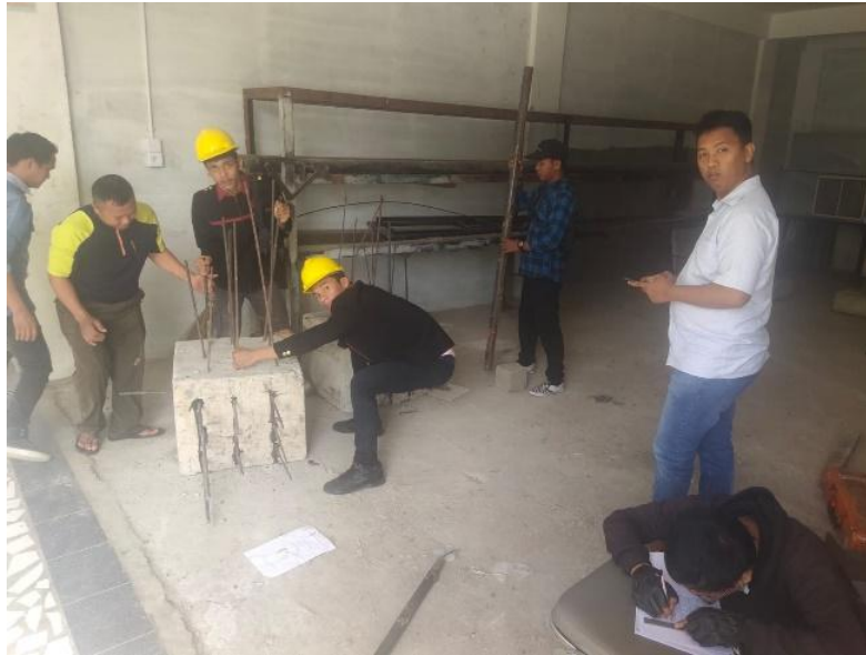
Gambar 5. Persiapan Uji Baja dibantu tenaga harian dan skill labor
