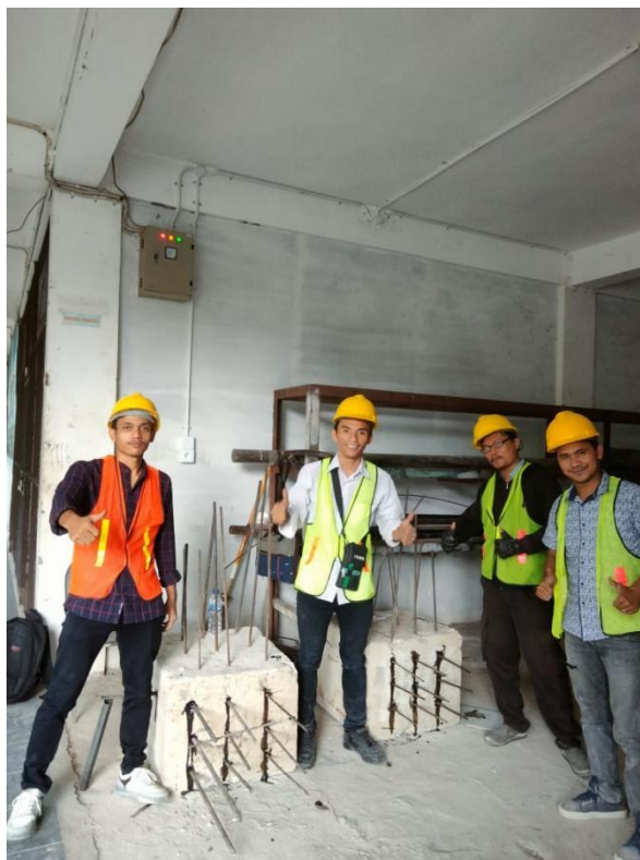
Gambar 4. Formasi Baja Tulangan terpasang dengan Epoxy
