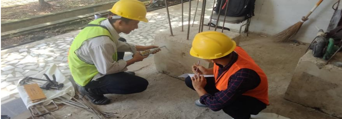
Gambar 1. Uji Tekan Hammer Test
