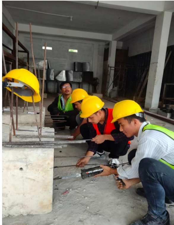
Gambar 3. Pemasangan Baja Tulangan dengan Epoxy
