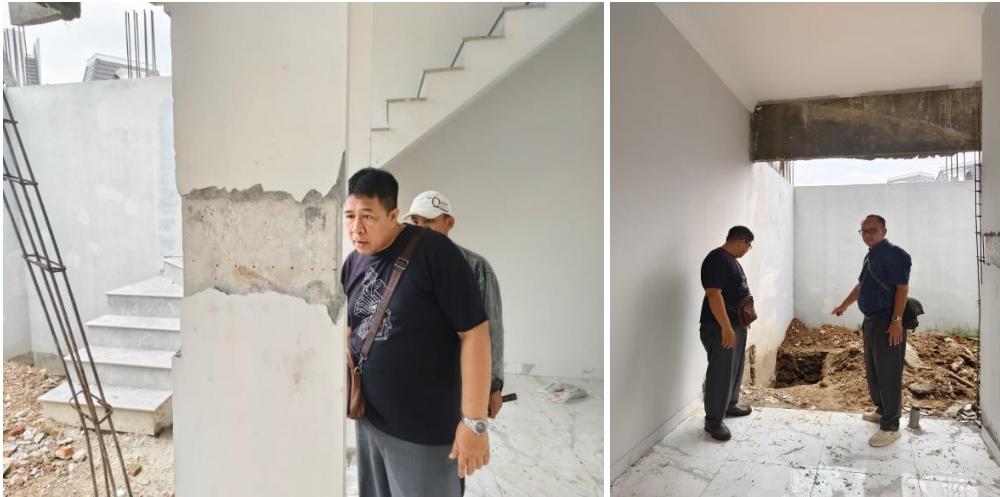
Gambar 1. Pemeriksaan Struktur dan Pondasi pada Lokasi Bangunan
