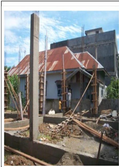
Gambar 9 : Bongkar mal kolom dan pemasangan mal kolom sedang dikerjakan pada proyek pembangunan Gedung Serbaguna GBKP Marendal – Mekatani Kabupaten Deli Serdang.
