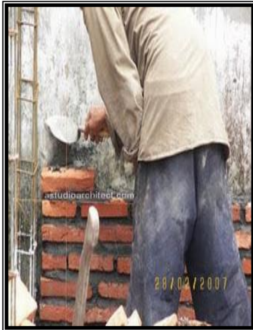
Gambar 5 : Tulangan kolom, sedang dikerjakan bersama pembuatan pasangan dinding bata.
