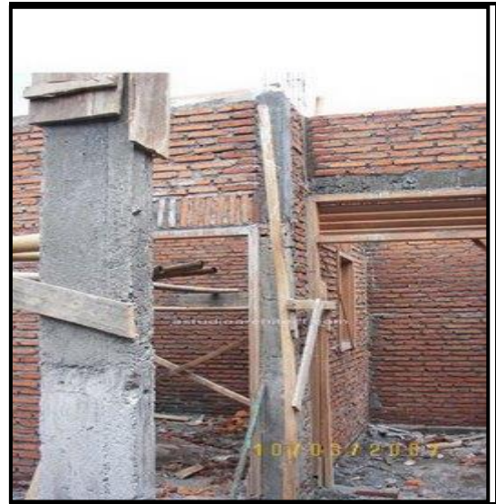
Gambar 7 : Pekerjaan kolom yang sudah jadi.
