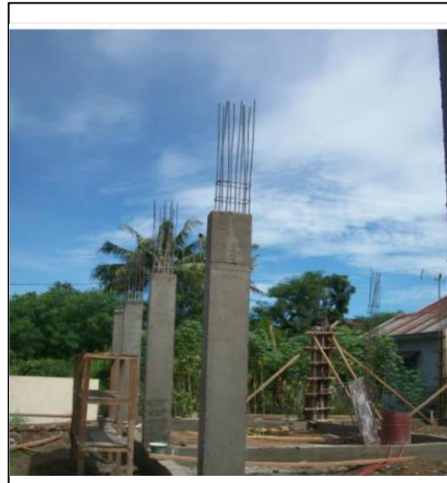
Gambar 10 : Bongkar mal kolom dan pemasangan mal kolom sedang dikerjakan pada proyek pembangunan Gedung Serbaguna GBKP Marendal – Mekatani Kabupaten Deli Serdang.
