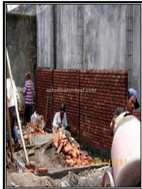
Gambar 4 : Tulangan kolom, sedang dikerjakan bersama pembuatan pasangan dinding bata.
