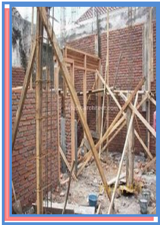
Gambar 6 : Tulangan kolom, sedang dikerjakan bersama pembuatan pasangan dinding bata.
