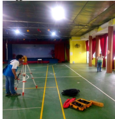
Gambar 1. Pengamatan Lendutan Lantai
