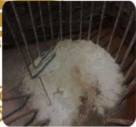
Gambar 2.13 Contoh Kepala Tiang Yang Bagus Atau Bisa Di Uji
