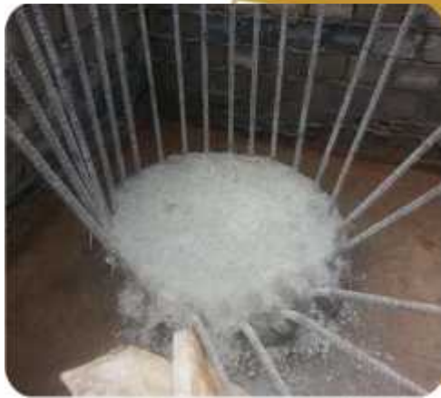
Gambar 2.13 Contoh Kepala Tiang Yang Bagus Atau Bisa Di Uji
