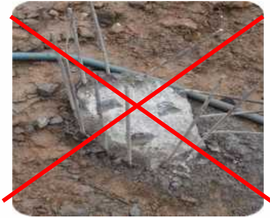
Gambar 2.12 Contoh Kepala Tiang Yang Tidak Bisa Di Uji
