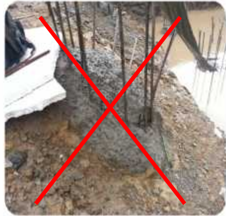
Gambar 2.12 Contoh Kepala Tiang Yang Tidak Bisa Di Uji
