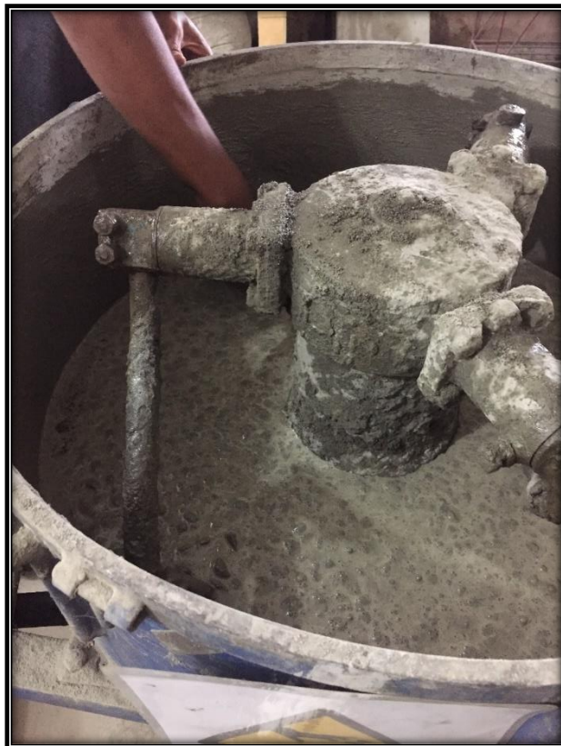
Foto 4: Proses pencampuran material beton.
