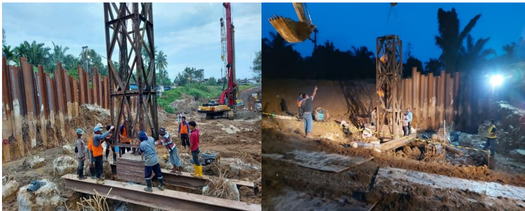
Gambar 2.10 Proses pemasangan alat PDA Test pada titik bore pile JAS-2
