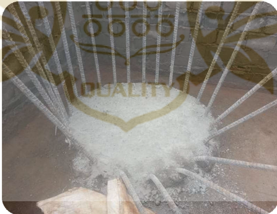
Gambar 2.6.2 Contoh kepala tiang yang bagus atau bisa di uji
