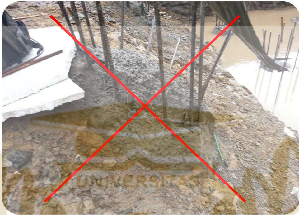
Gambar 2.6.1 contoh kepala tiang yang tidak bisa di uji
