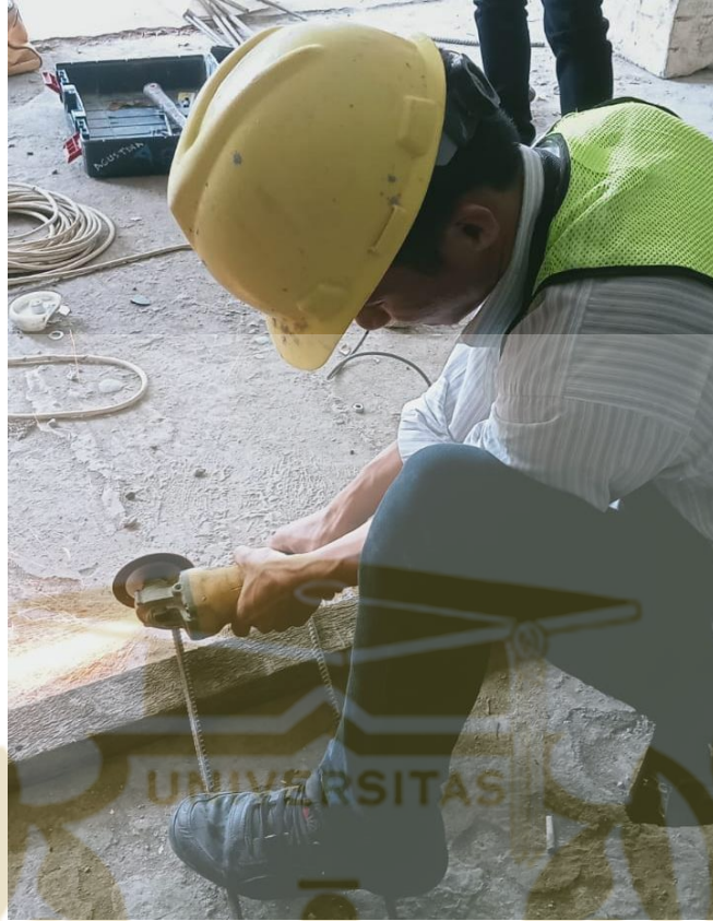
Pemotongan tulangan baja sirip
