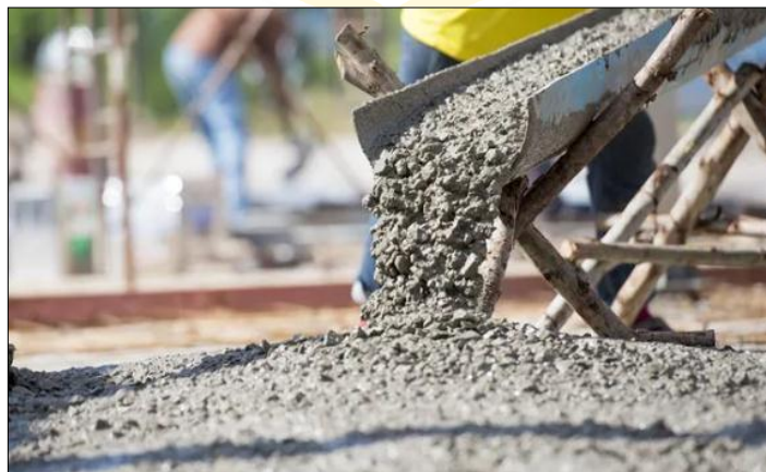
Gambar 2.4 Semen campur air, pasir, dan kerikil (beton)
