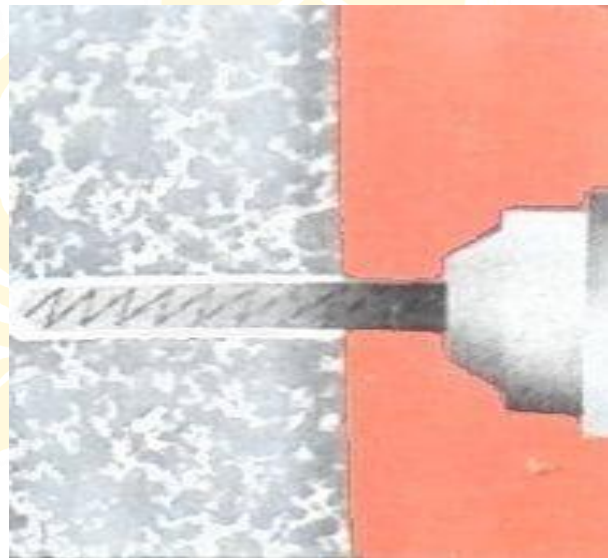
Gambar 2.7 pengeboran beton eksisisting
