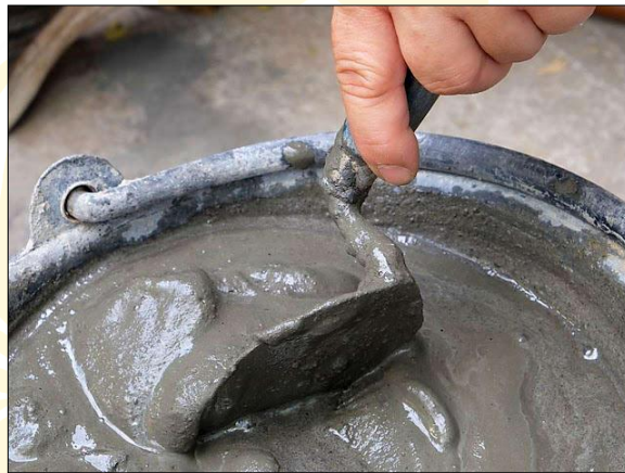
Gambar 2.3 Semen campur air dan pasir (mortar)
