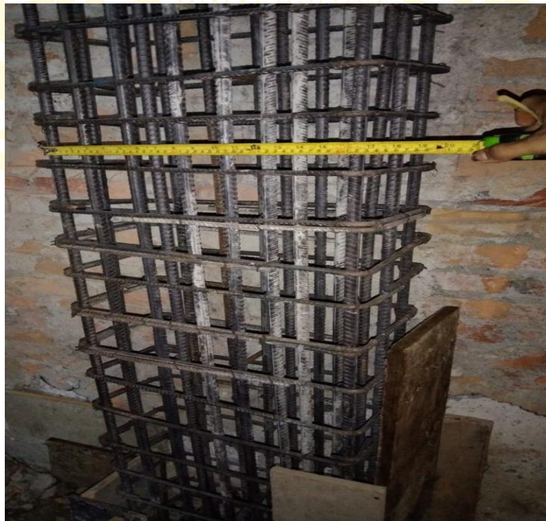
Gambar: 2.4. Jarak Penulangan Kolom Jacketing
