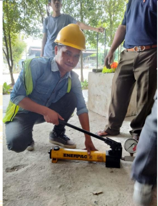
Pemompanan alat uji hidrolik untuk memberi beban tarik
