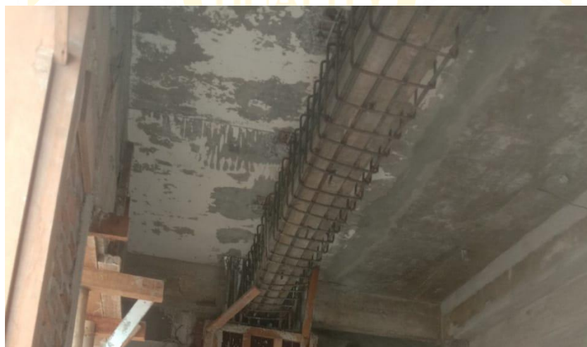
Gambar 2.1 balok yang akan dilakukan perkuatan struktur
