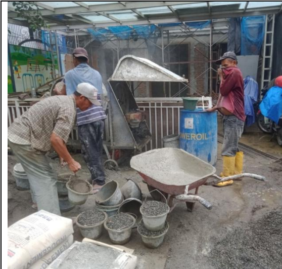
Gambar dokumentasi Pencampuran Agregat
