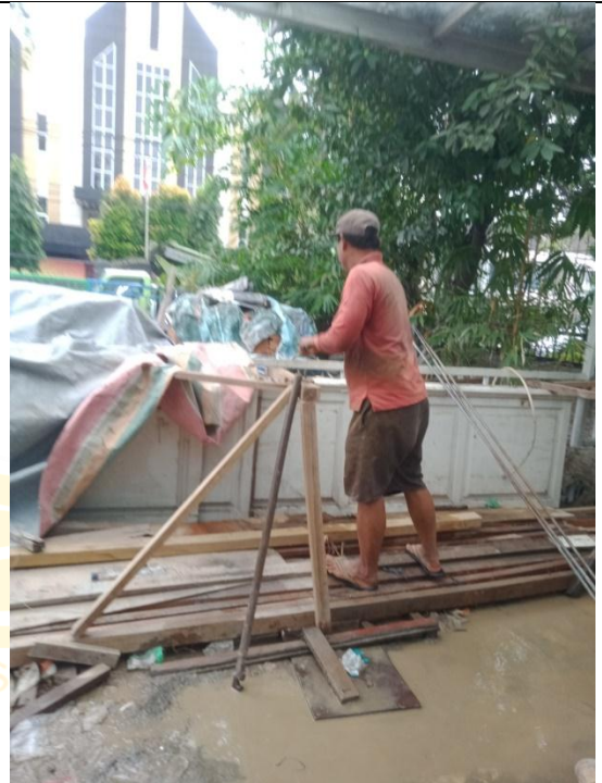
Gambar Dokumentasi Pembengkokan Besi
