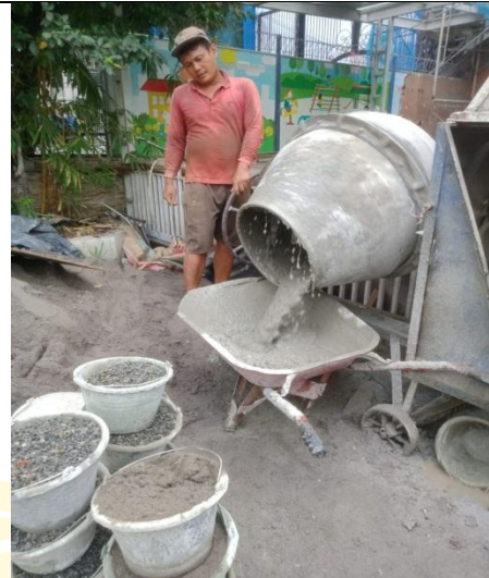
Gambar dokumentasi persiapan pengecoran
