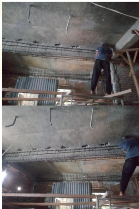
Gambar dokumentasi Pemasangan Besi untuk Jacketing
