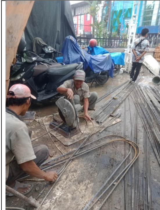
Gambar Dokumentasi Pemotongan Besi
