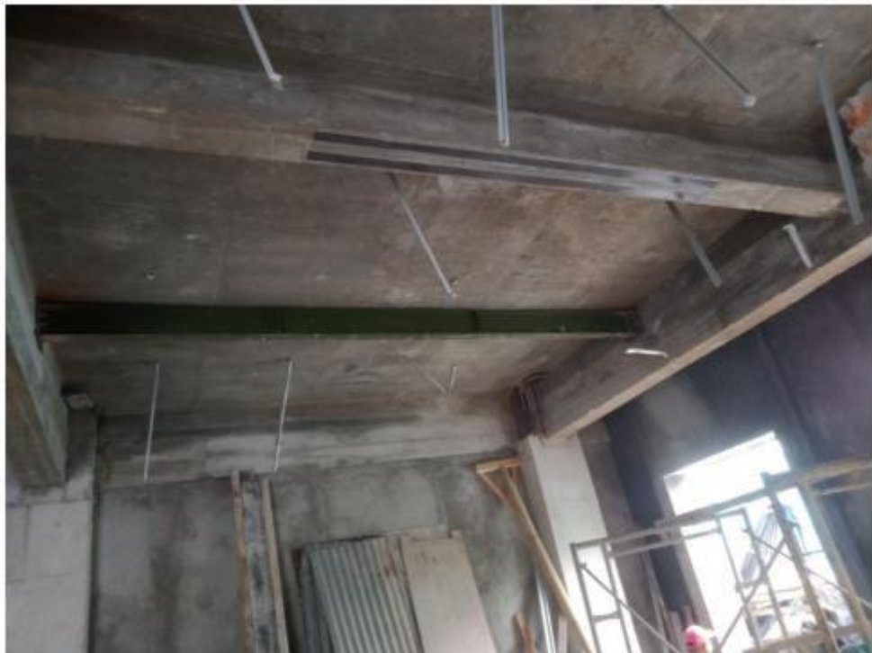
Gambar dokumentasi Kolom Yang sudah siap dicor dan dipasangkan plat CFRP
