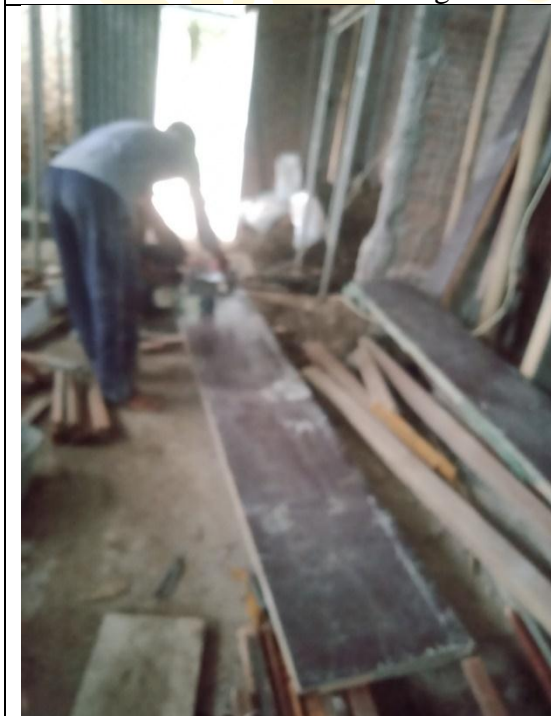
Gambar Dokumentasi Pemotongan Bekisting
