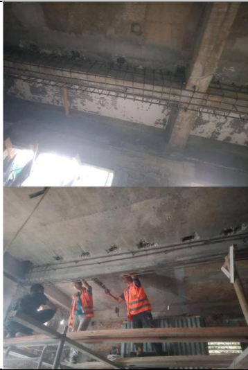
Gambar dokumentasi Pembesian Balok
