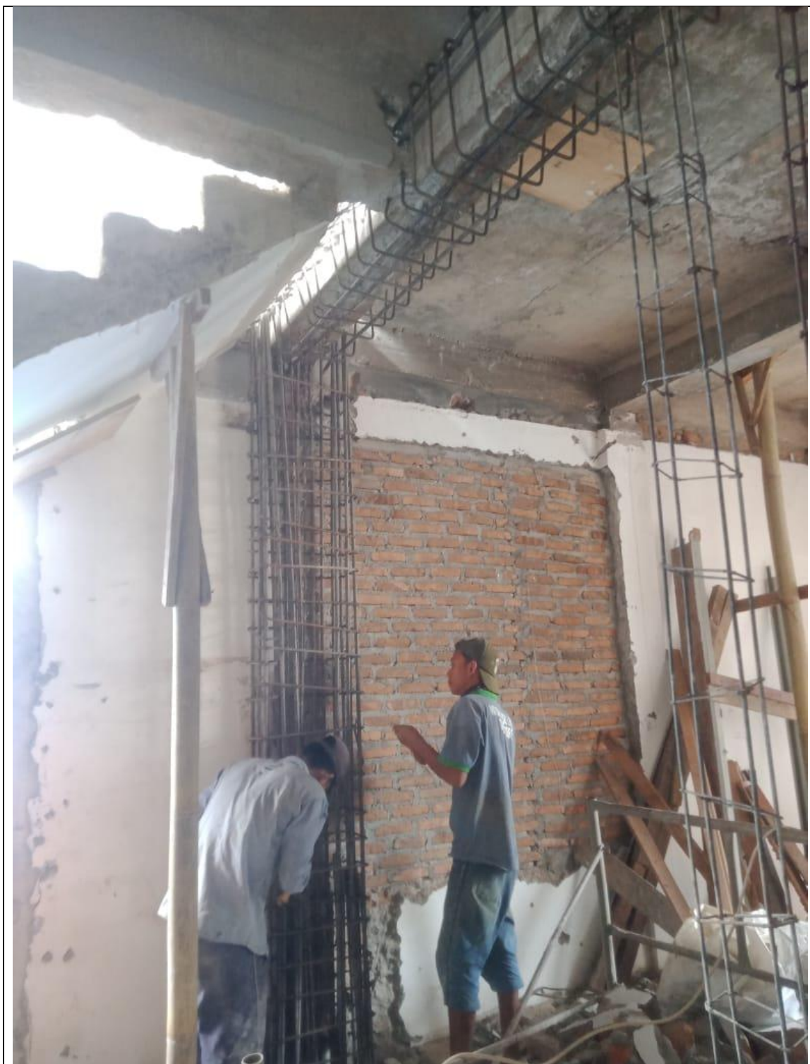
Gambar Dokumentasi Perakitan Besi untuk Balok dan Kolom
