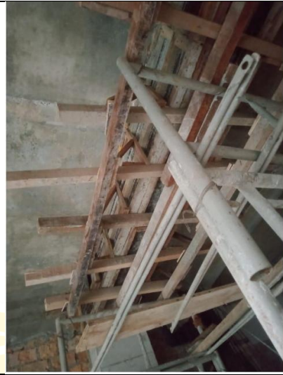
Gambar dokumentasi Pemasangan Bekisting Balok
