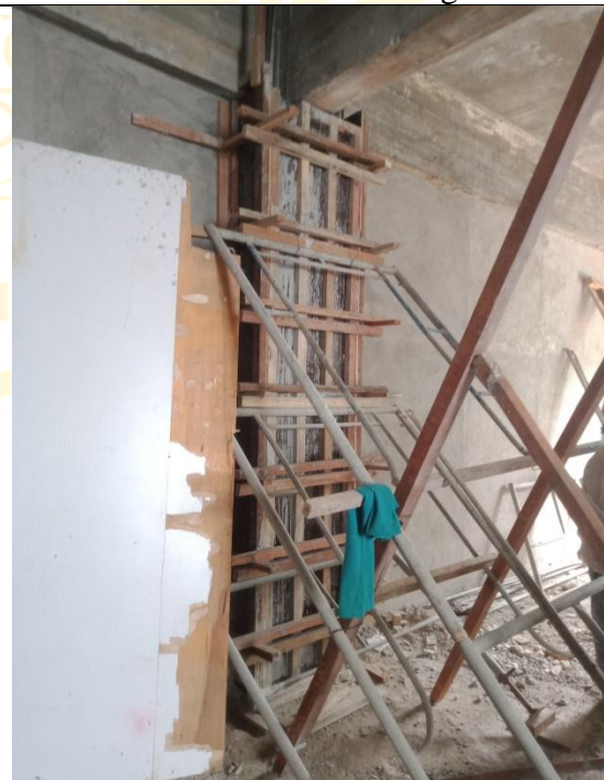
Gambar Dokumentasi Perakitan Bekisting
