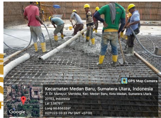
FOTO XLVIII Pengecoran Pelat Lantai Sumber: Foto Pribadi
