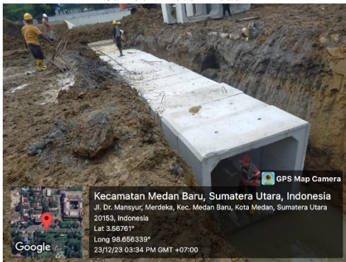
FOTO XXIII Pemasangan Box Sumber: Foto Pribadi
