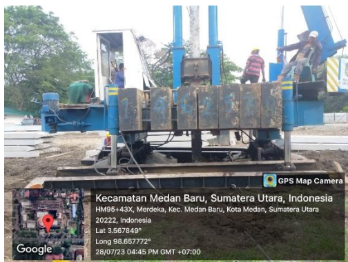
FOTO IX Pemancangan Minipile Sumber: Foto Pribadi
