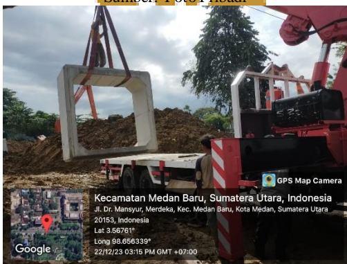
FOTO XXV Erection Box Sumber: Foto Pribadi
