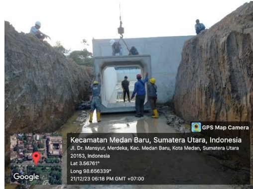
FOTO XXII Erection Box Sumber: Foto Pribadi
