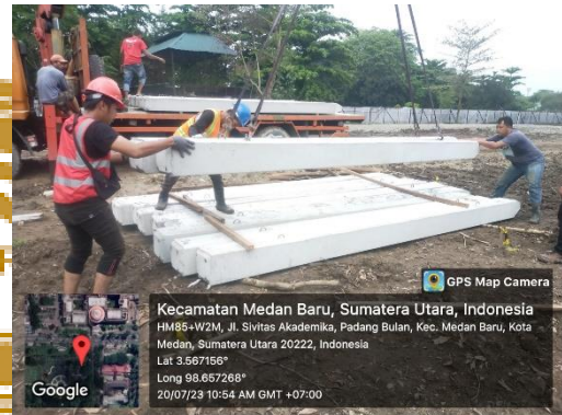
FOTO IV Erection Minipile Sumber: Foto Pribadi
