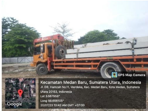
FOTO I Minipile On Site Sumber: Foto Pribadi
