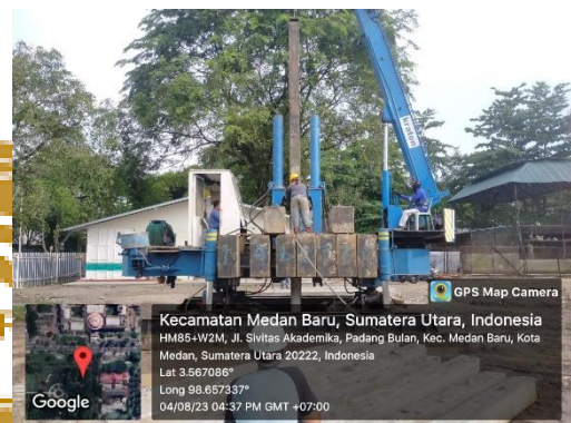
FOTO X Pemancangan Minipile Sumber: Foto Pribadi
