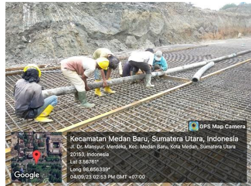
FOTO VIII Pengecoran Pelat Lantai Sumber: Foto Pribadi
