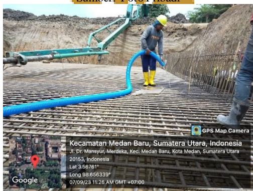
FOTO XVII Persiapan Pengecoran Sumber: Foto Pribadi
