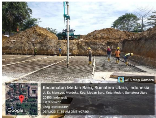
FOTO XXIX Pengecoran Pelat Lantai Sumber: Foto Pribadi
