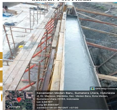
FOTO XVI Pengecoran Dinding Sumber: Foto Pribadi
