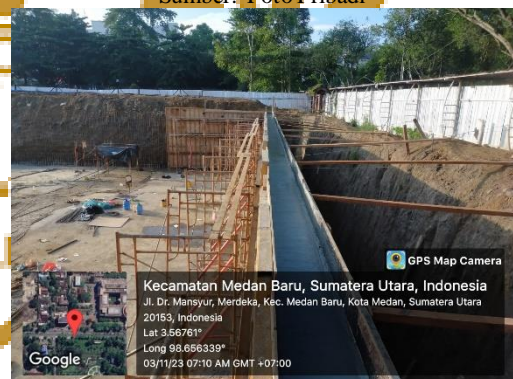
FOTO L Pengecoran Dinding Sumber: Foto Pribadi
