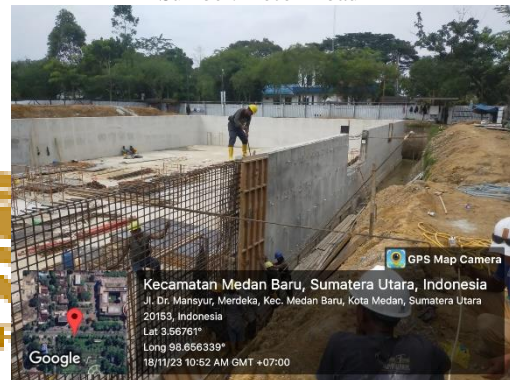
FOTO XXXII Pemasangan Bekisting Sumber: Foto Pribadi
