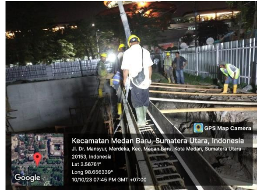
FOTO XXXVIII Pengecoran Dinding Sumber: Foto Pribadi
