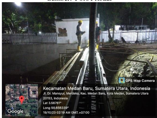
FOTO XLIII Pengecoran Dinding Sumber: Foto Pribadi
