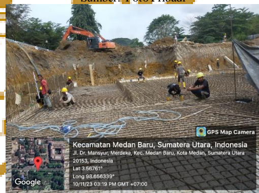
FOTO XXXIV Persiapan Pengecoran Sumber: Foto Pribadi
