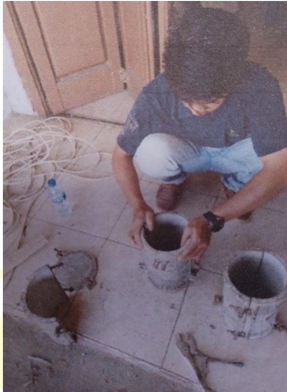
Pemasangan tabung silinder
