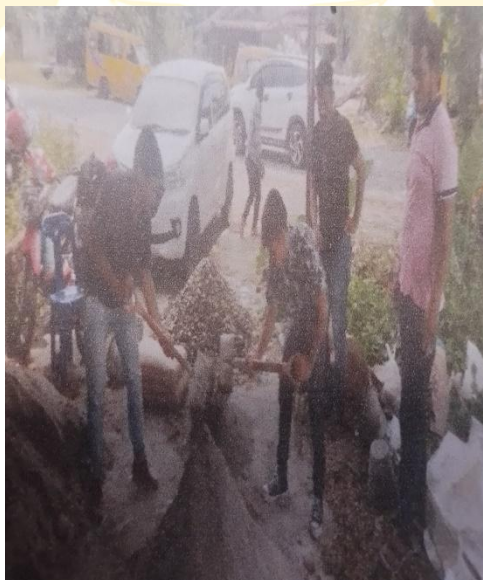
Pencampuran material beton
