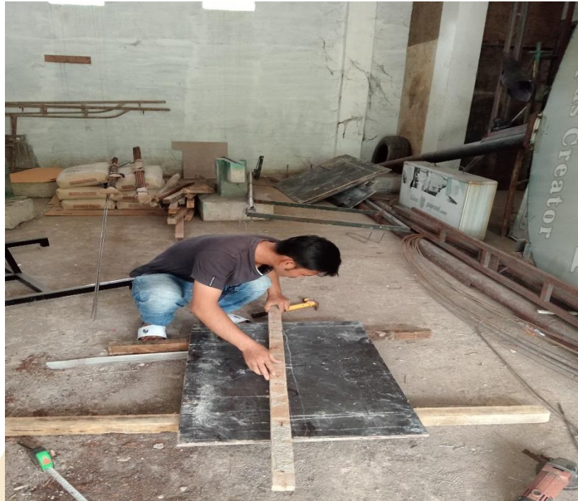
Pembuatan bekisting/mall
