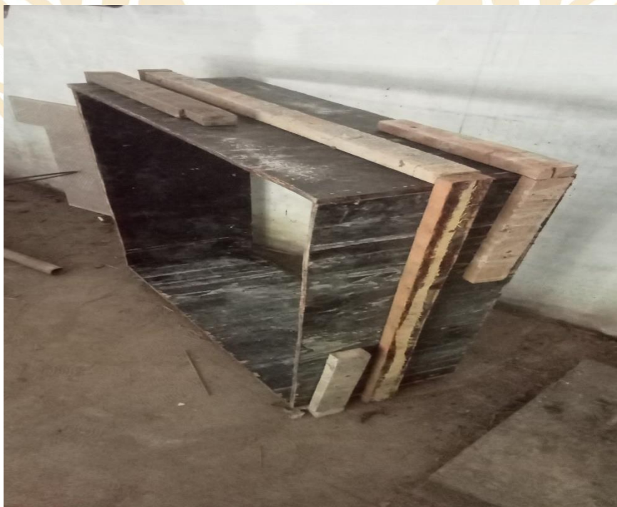
Bekisting/mall tapak pondasi
