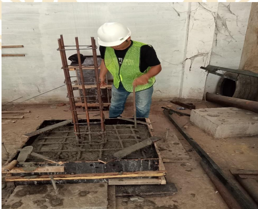
Pengecoran Benda Uji pada Tapak Pondasi
