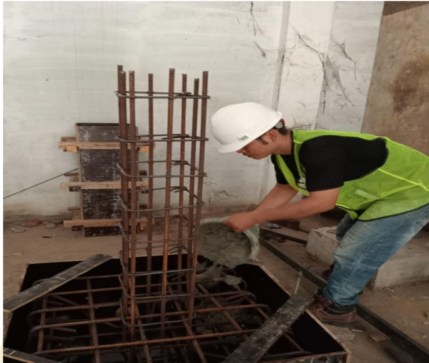
Pengecoran Benda Uji pada Tapak Pondasi
