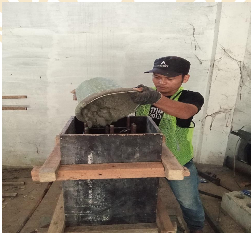
Pengecoran Benda Uji pada Kolom
