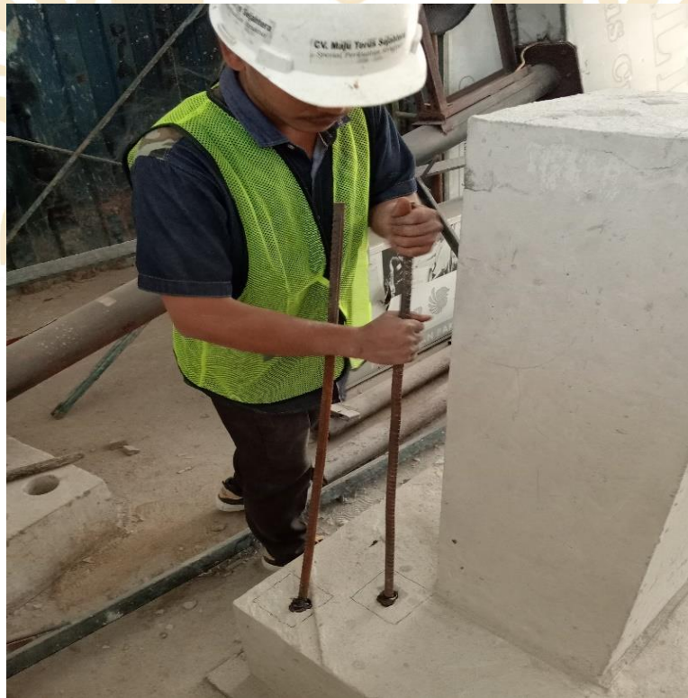
Pemasangan Rebar
