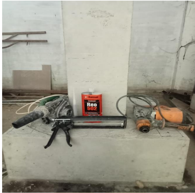
Alat Dan Bahan Yang Digunakan Pada Pemasangan Rebar
