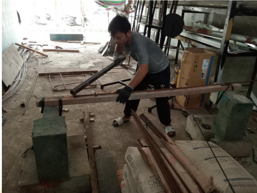
Pembengkokkan besi tulangan
