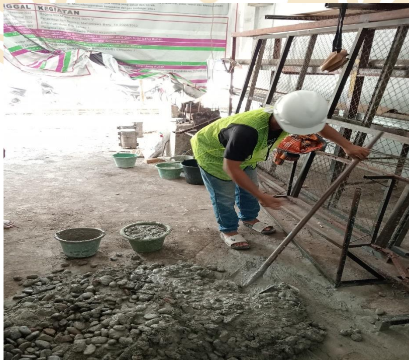
Pengadukan beton manual
