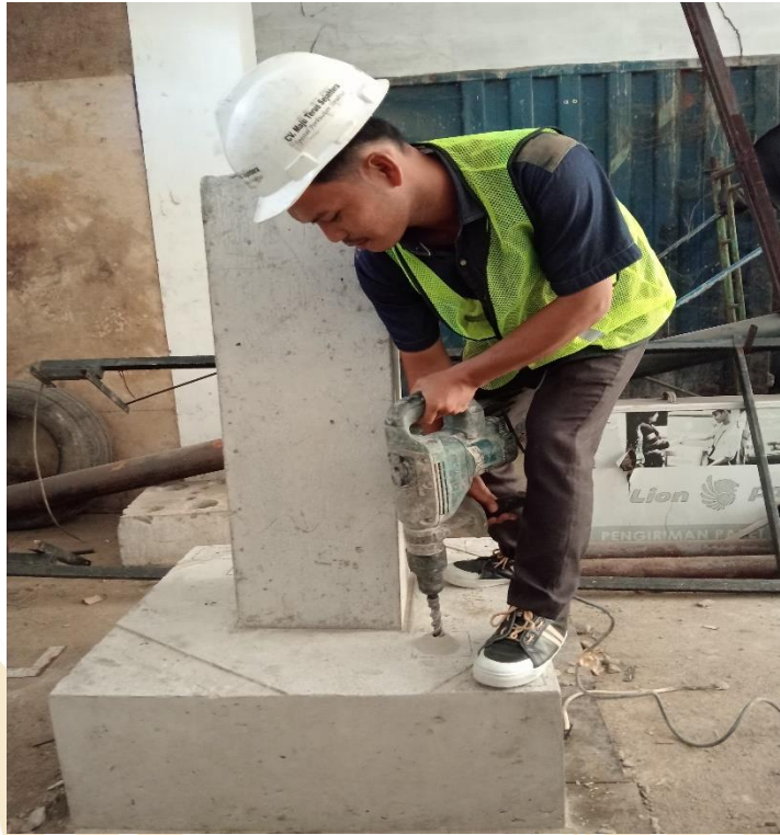
Pengeboran Beton Uji
