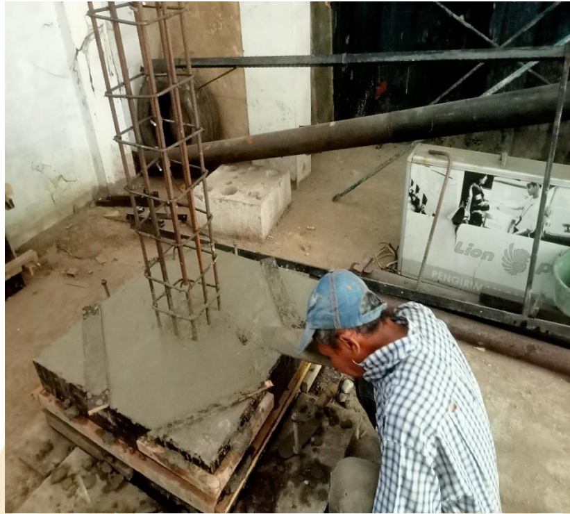
Hasil pengecoran tapak pondasi
