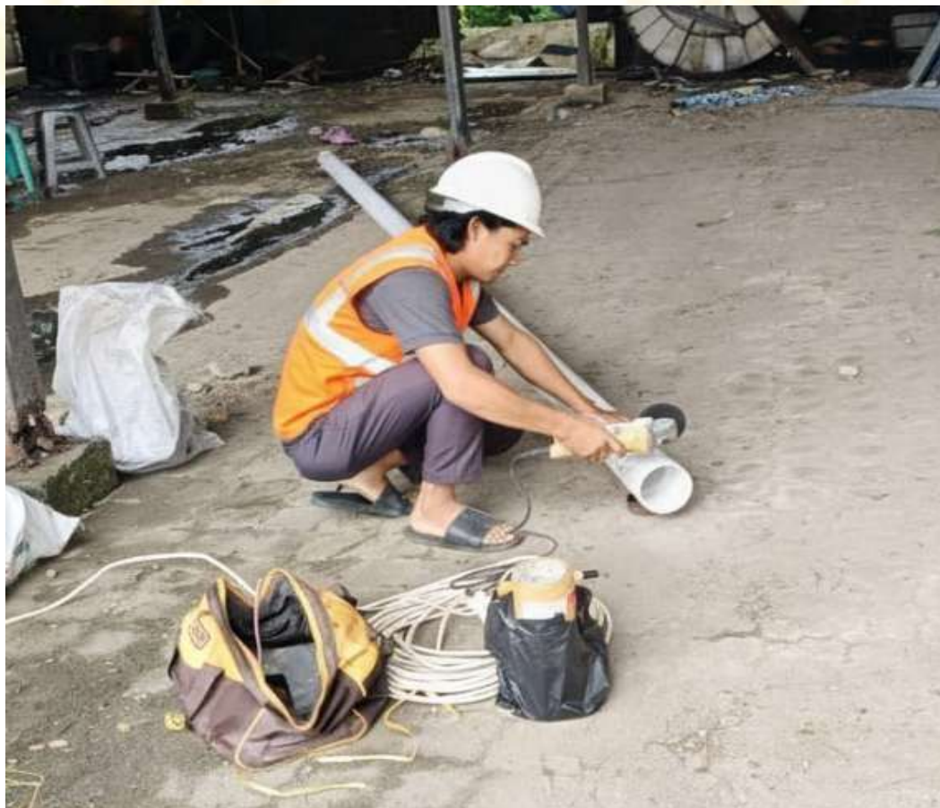
Proses pemotongan pipa 4 inc sebagai ganti cetakan silinder
