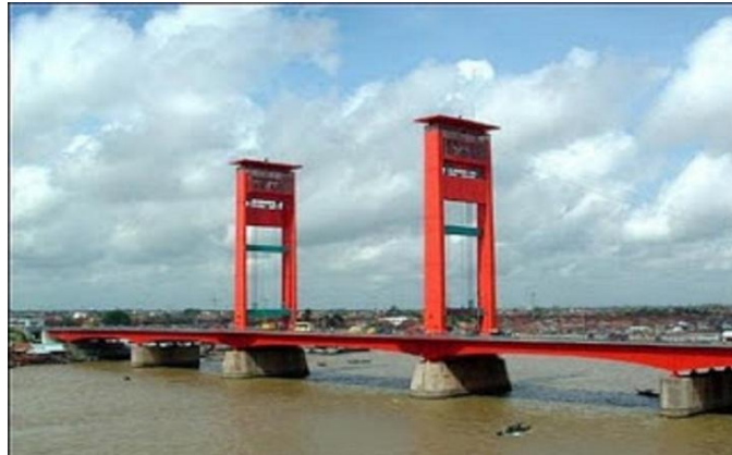
Gambar 2. 14 Jenis Kenampakan Buatan (Jembatan)
