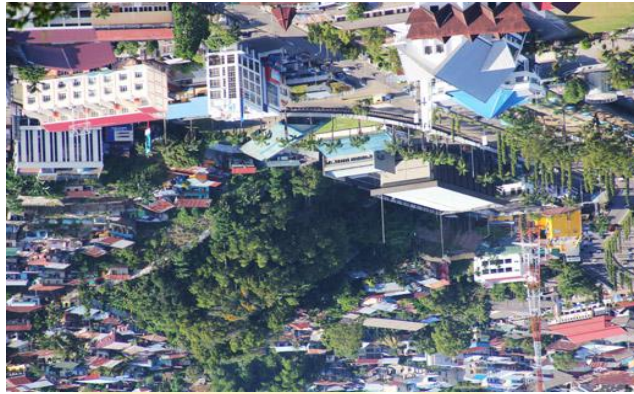
Gambar 2. 11 Jenis Kenampakan Buatan (Rumah dan Pemukiman)
