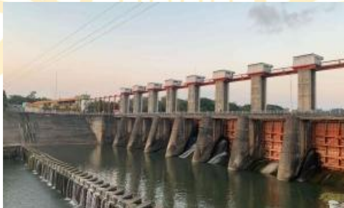
Gambar 2. 15 Jenis Kenampakan Buatan (Bendungan)
