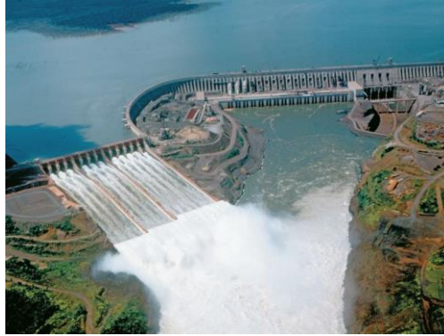
Gambar 2. 3 Pembangkit Listrik Tenaga Air (PLTA)
