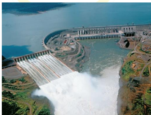
Gambar 2.2 Pembangkit Listrik Tenaga Air (PLTA)
