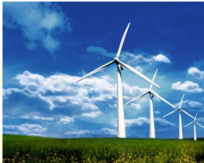
Gambar 2. 3 Pembangkit Listrik Tenaga Bayu (PLTB)
