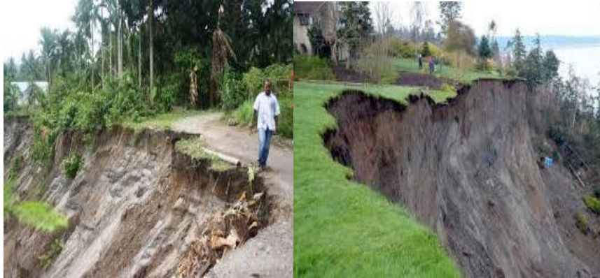
Gambar 2.1 Erosi dan Longsor
