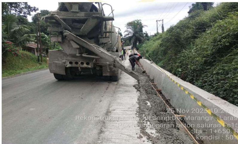
Photo Pekerjaan Beton struktu Fc'15
