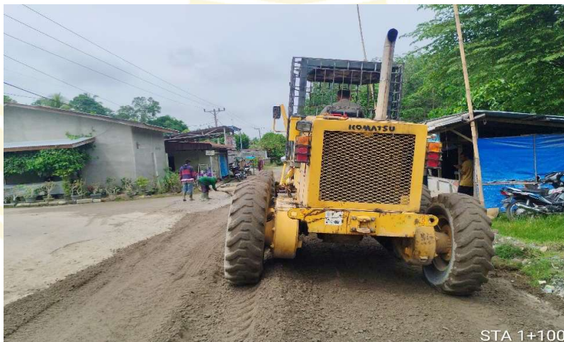
Photo Pekerjaan Agregat Kelas A
