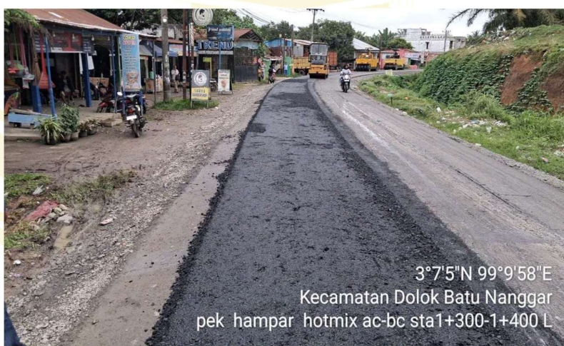
Photo Pekerjaan Lapis Aus AC-BC
