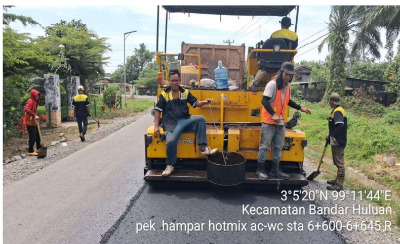
Photo Pekerjaan Lapis Aus AC-WC
