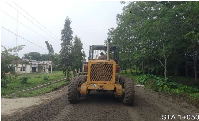
Photo Pekerjaan Agregat Kelas B
