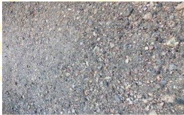
Gambar 2.16 Kerusakan Pelepasan Butir ( Ravelling )
