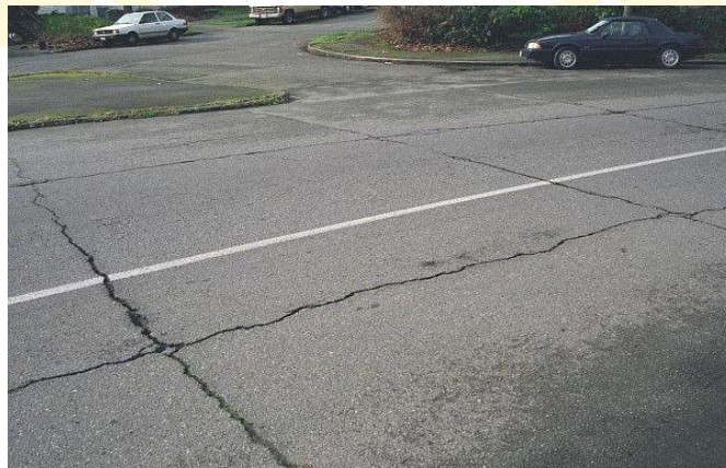
Gambar 2.8 Kerusakan retak refleksi ( Reflection Cracking )
