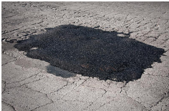
Gambar 2.19 Tambalan ( Patching ) Sumber: https://tekniksipil.id/apa-itu-patching-aspal/
